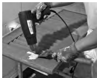
CHAUFFER LES MATÉRIAUX PEINTS
