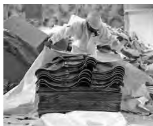
DÉPOSE DE FIBROCIMENT
