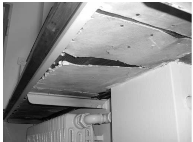
Carton d'amiante accessible fixé sous un appui de fenêtre, photo Laboratoire cantonal de Bâle-Ville
