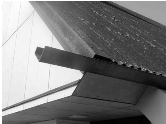
Toiture ondulée en fibrociment, photo IST
