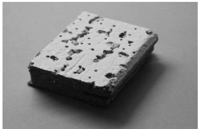
Partie d'un panneau acoustique (faux plafond) contenant de l'amiante, photo IST
